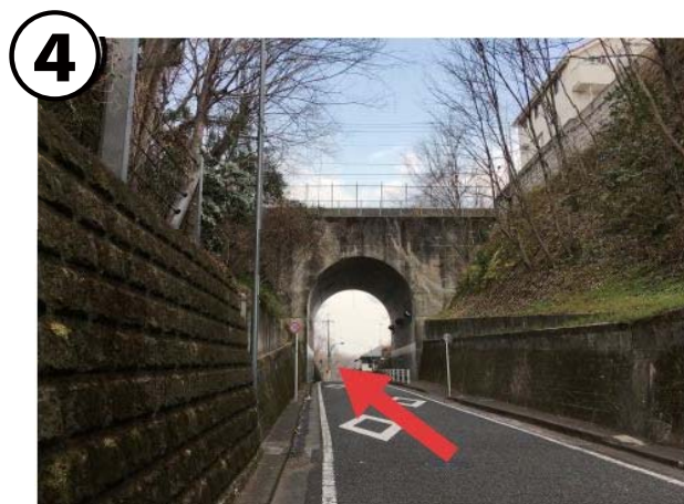
弁天橋下をくぐる
